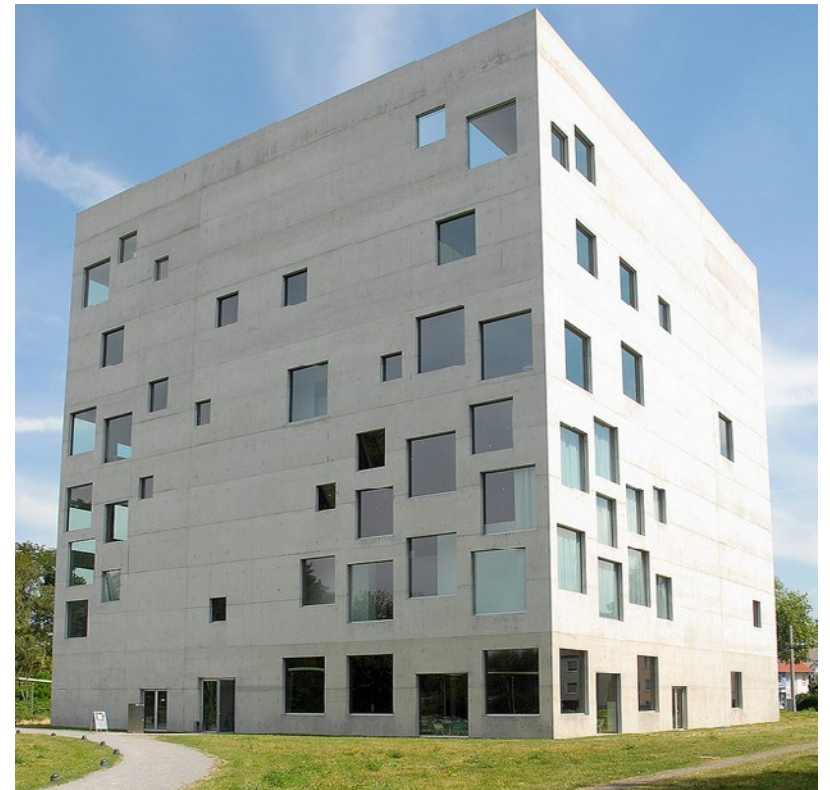
Sanaa Gebäude, Zollverein Essen
